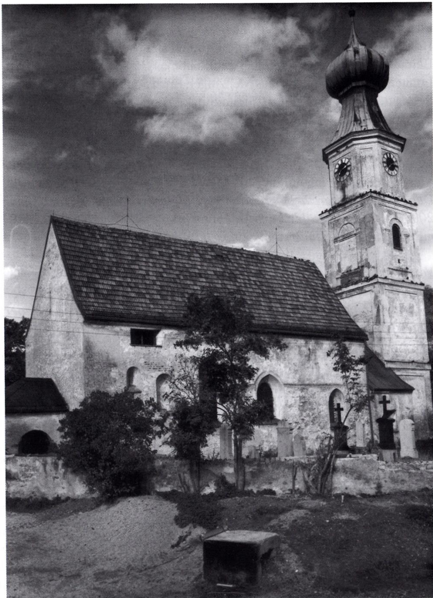
Dorfkirche St. Georg vor der Renovierung und Abräumung der alten Grabsteine, also vor 1969.
